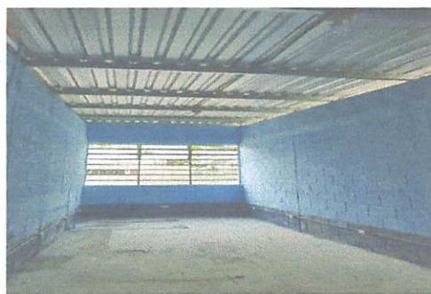
Foto 6: Levantado de pared para desnivel de techo
