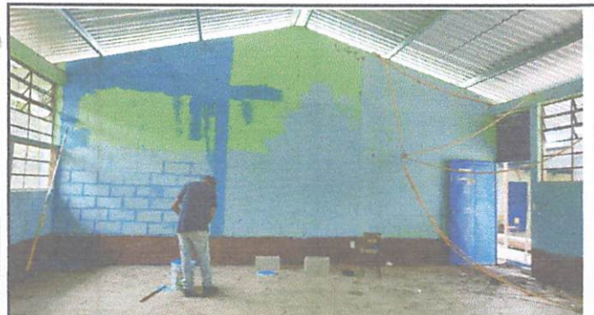
Foto 3: Paredes y pintura
