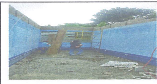
Foto 6: Levantado de pared para desnivel de techo
