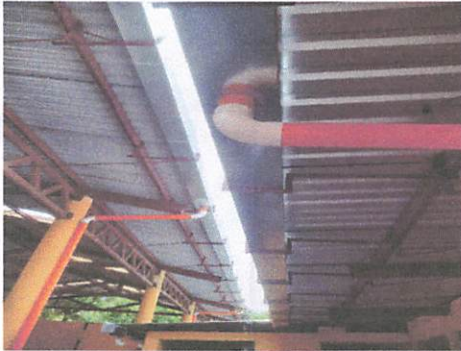
COLOCACIÓN DE BAJADAS DE AGUA
