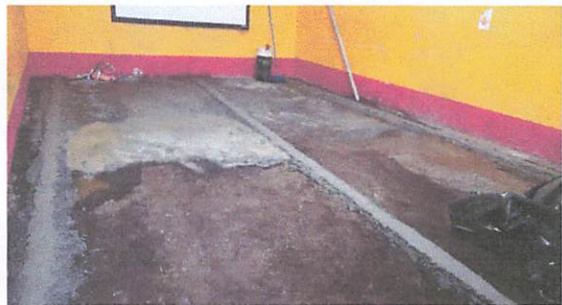
NIVELACIÓN DE TERRENO PARA COLOCAR PISO
