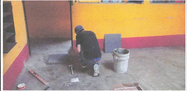
COLOCACIÓN DE PISO EN LAS AULAS
