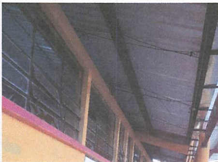
COLOCACIÓN DE CANALETAS
