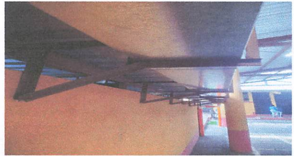
COLOCACION DE CANALETAS
