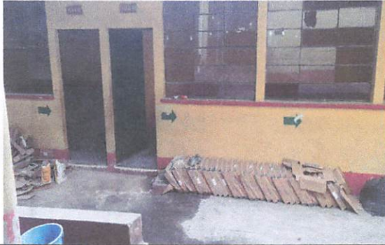
INICIO DE LOS TRABAJOS EN LS AULAS
