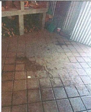
FOTO 3: Sustitución de piso adoquin por piso ceramico
