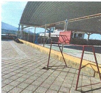
FOTO 11: Ampliación de muro perimetral
