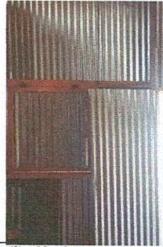
FOTO 2: sustitución de ventanas de cocina
