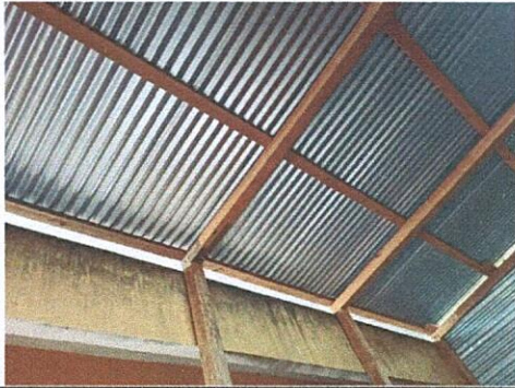
FOTO 7: Sustitución y reparación de techo con vigas de metal
