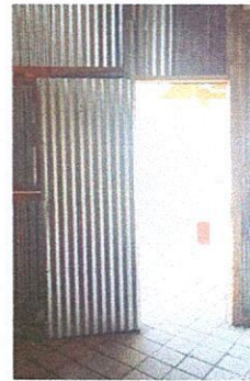
FOTO 8: Sustitución de puerta de lámina por puerta de metal
