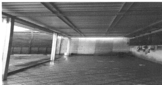
se aprecia un escenario distinto al contar con el techado
