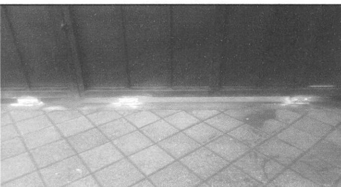
Reparación y colocación de rodos del porton de entrada
