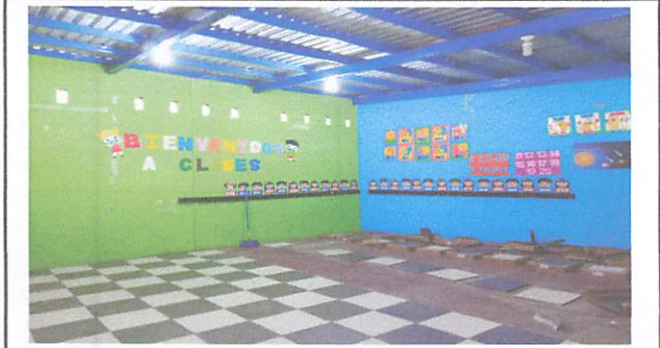
Foto1: Colocando Piso Ceramico
