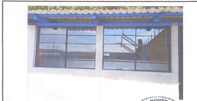
Foto 5: Intalacion de balcones.
