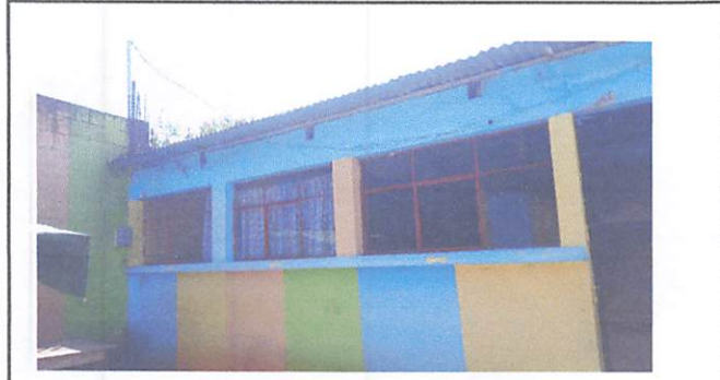
Foto 3: Techado parte del corredor.
