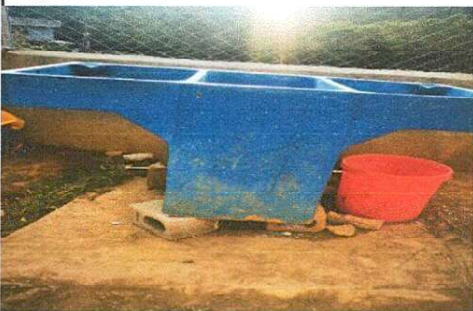
Foto 5: pila en malas condiciones
