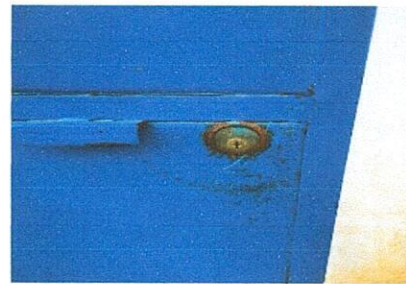
Foto 4: chapa descompuesta
