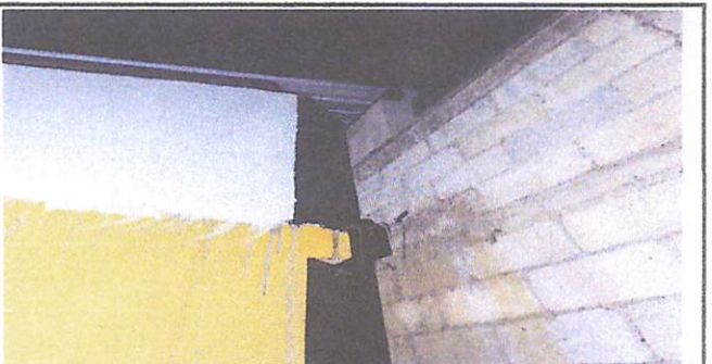
fotografía de elevación de pared parte de atrás y enlaminado de salones planta alta. 06/05/2024
