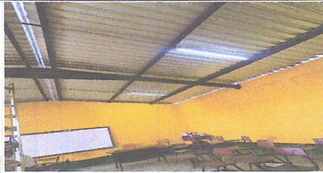
Fotografía dentro de salón de clases planta baja finalizado. 06/05/2024
