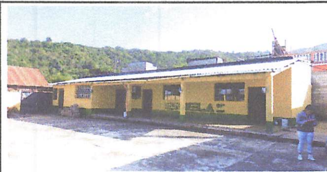
Culminación de enlaminado de los salones planta alta, 06/05/2024
