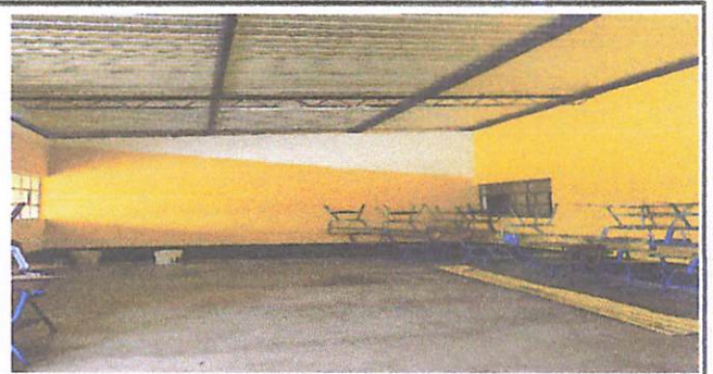
Fotografía de salón parte interior enlaminado y elevación de paredes planta alta, 06/05/2024
