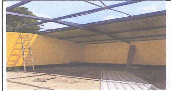
Enlaminando planta baja 26/04/2024
