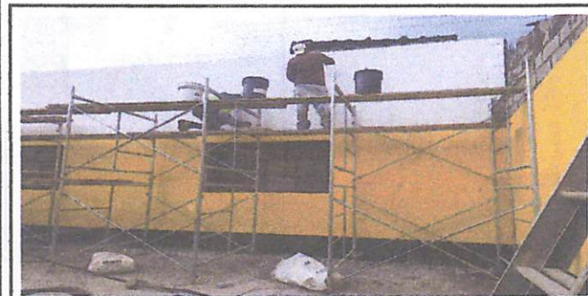
elevacion de paredes de dos aulas planta alta 26/04/2024
