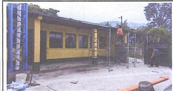
colocacion de canales y bajadas de agua pluviales 26/04/2024
