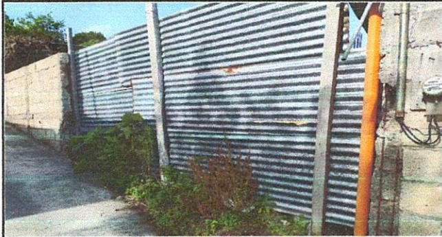
Foto 1: Remozamiento de muro de contención, esto debido al colapso de muro perimetral. 30 metros lineales. Módulo 1
