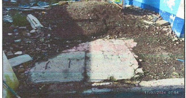
Foto 2: Remozamiento de torta de concreto, ubicado en módulo 3. 49 metros cuadrados.
