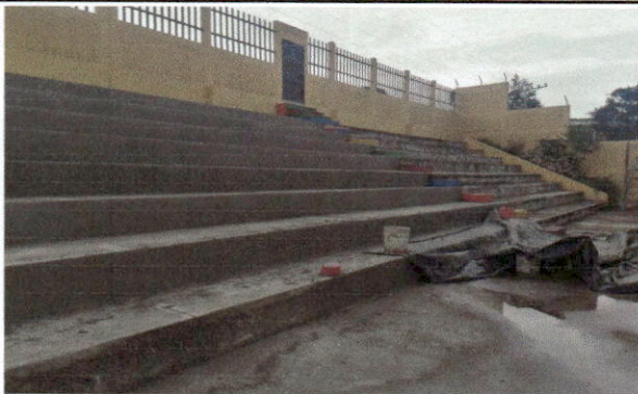
Foto 3: Trabajo de repación de las gradas.
