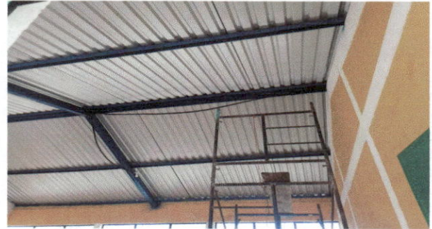
Foto 2: Realizando los últimos detalles de colocación de lamina nueva.
