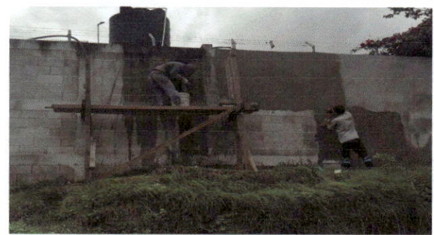
Foto 6: Avanzando en el repello de la pared.
