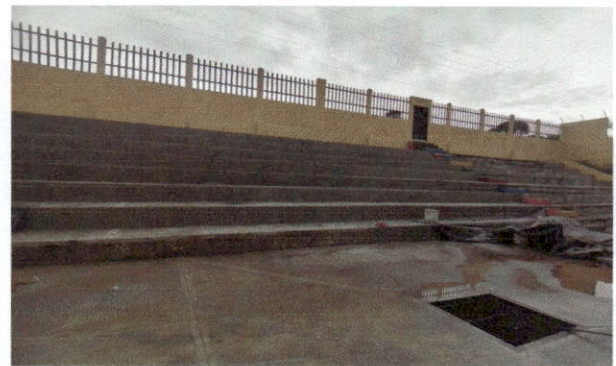
Foto 4: Reparación de gradas.
