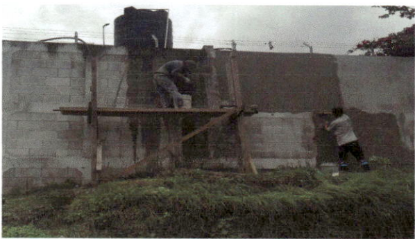
Foto 5: Trabajo de repello de pared.
