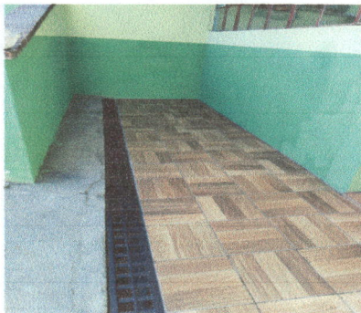
Foto 3: Fabricación y sustitución de parrilla metálica por deterioro.
