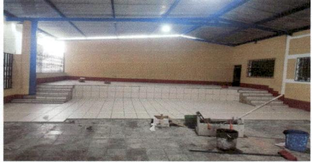
Foto 2: Avanzando en la colocación de piso.
