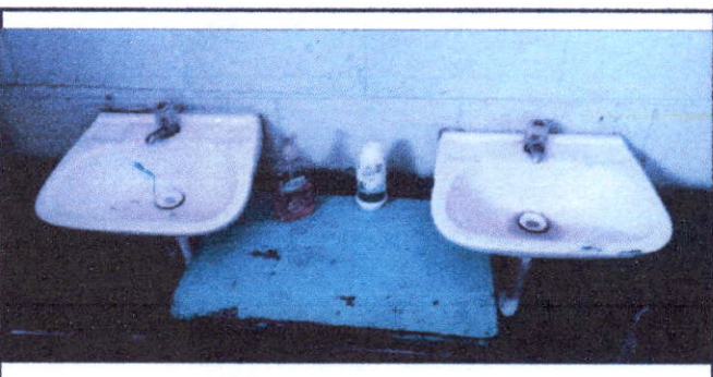
Lavamanos sanitarios de maestros
