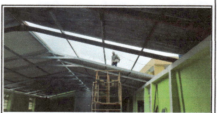
Foto 6: proceso de culminación de la colocación de las laminas.
