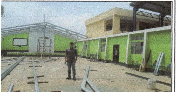
Foto 4. Colocación de las bigas y costaneras galvanizadas.
