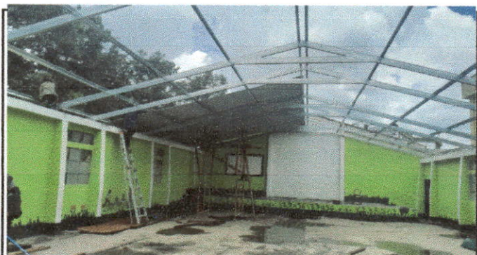
Foto 5: colocación de las nuevas laminas.
