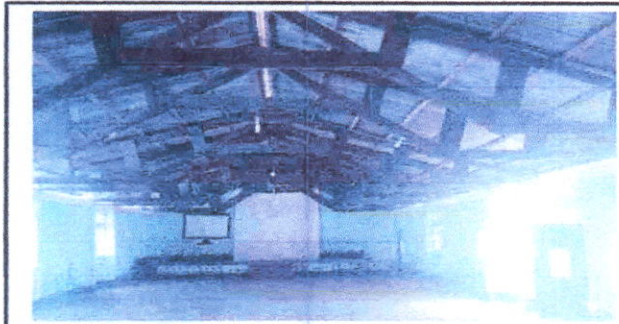
Foto 6: Capotes en mal estado donde se filtra el agua, en época lluviosa.
