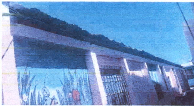
Foto 1: Las laminas estan muy pandeadas y dobladas.
