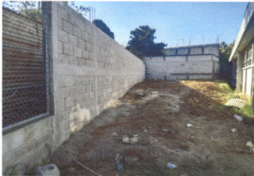
Foto 3: Otra vista del muro perimetral construido en el predio donde se ubica el establecimiento educativo
