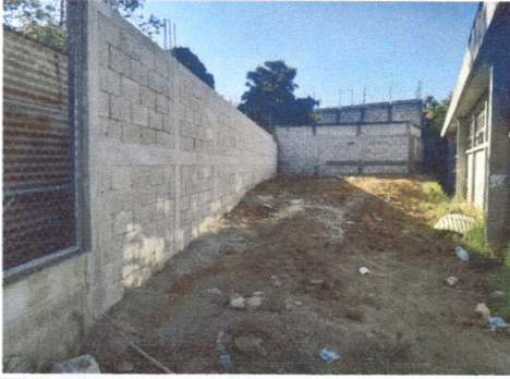
Foto 1: Muro perimetral finalizado
