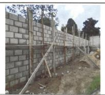
Foto 3: Fundiendo las columnas del muro perimetral en construcción.
