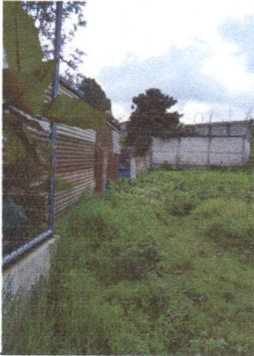
Foto 1: Área donde se requiere construir muro perimetral
