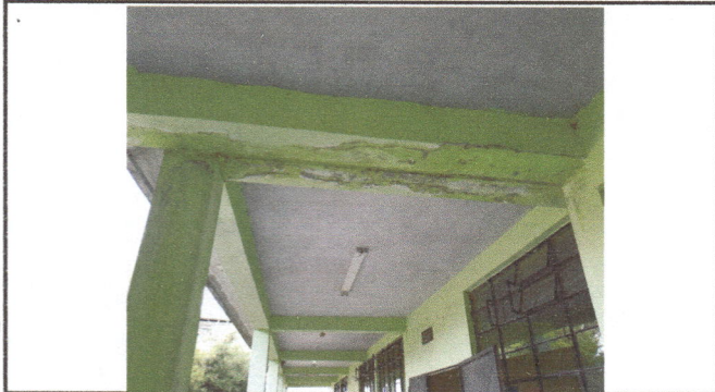
Foto 7: Parte de la loza a impermeabilizar
