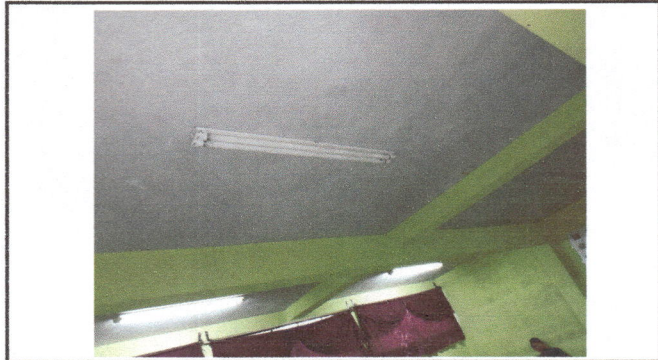
Foto 8: reparación de la iluminación de los salones de clases
