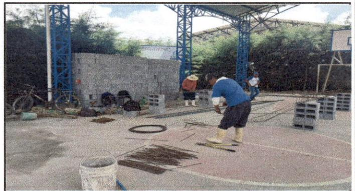
Foto 2: Muestra la preparación de columnas.
