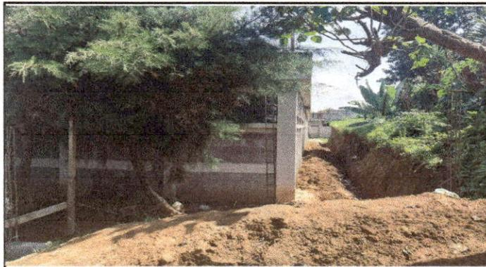
Foto 3: Muestra el sanjeado de la parte de atrás del edificio.
