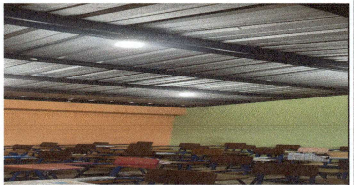
Foto 6: reparación de sistema eléctrico: cambio de focos led
