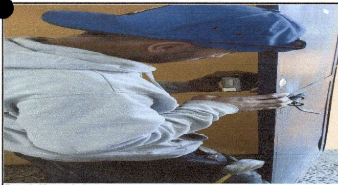
Foto 5: Mantenimiento a puertas: cambia de chapas
