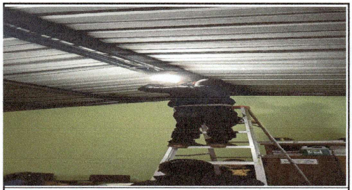
Foto 6: reparación de sistema electrico: cambio de focos led
