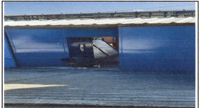
Foto 4: Cambio de portón
