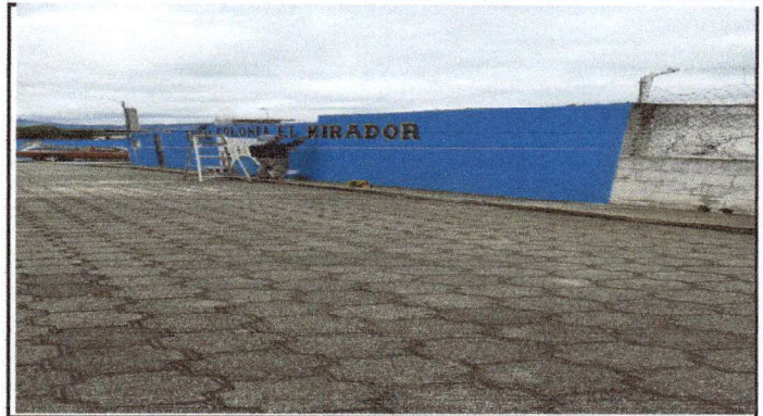
Foto 2: Pintado en mano de obra de interior y exterior
