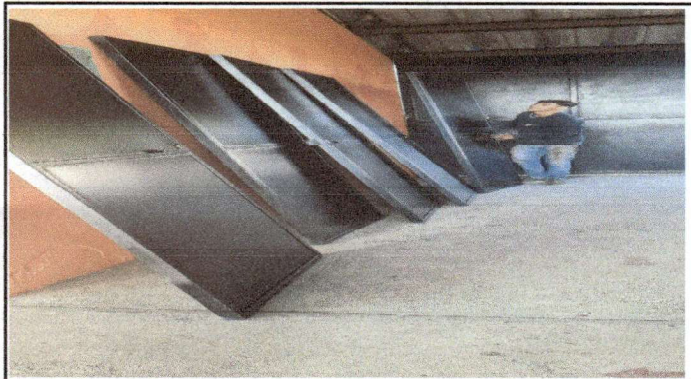
Foto 3: Cambio de puertas
