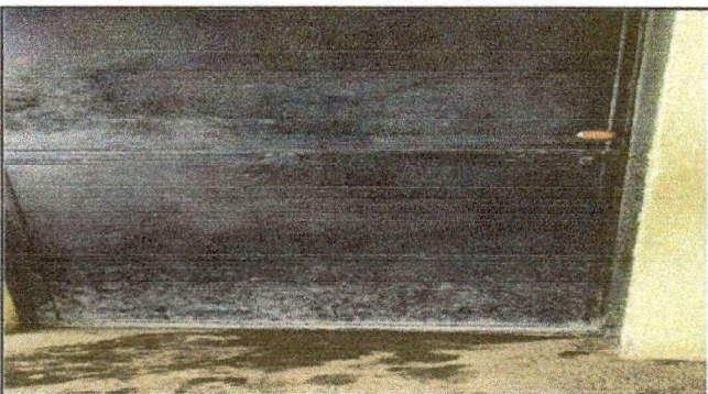
Foto 3: Cambio de puertas
