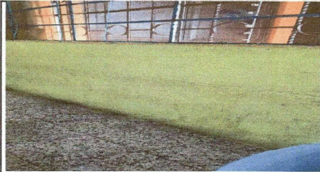
Foto1: Pintura en muros interior y exterior
