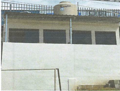
Foto 1 Remodelación de sanitarios.
