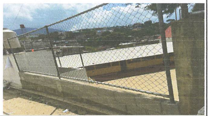
Foto 2 Levantado de block y reparación de malla
