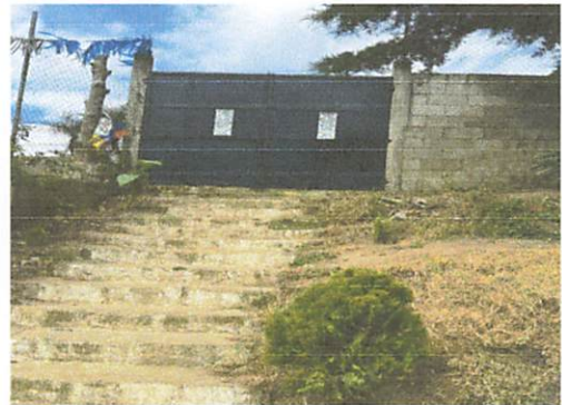
Foto 4 Cambio de portón
