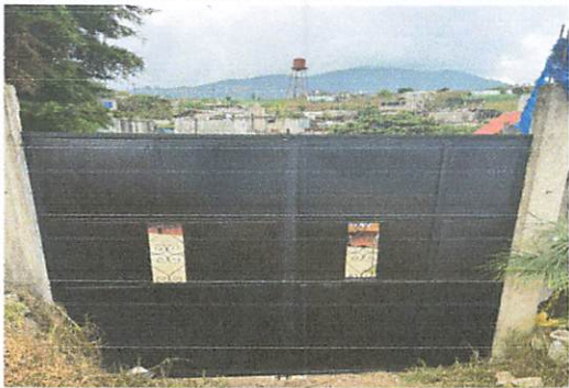
Foto 5 Cambio de portón
