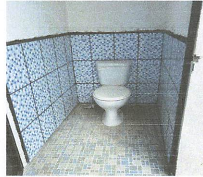
Foto 4. Remodelación de sanitarios.
