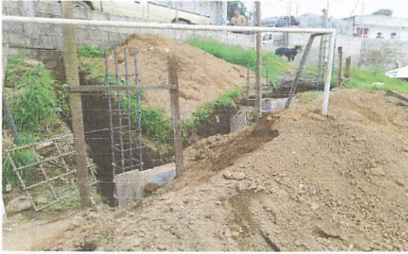
Foto 1 Remodelación de sanitarios.
