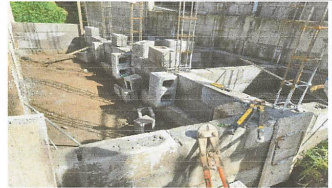
Foto 2. Remodelación de sanitarios.
