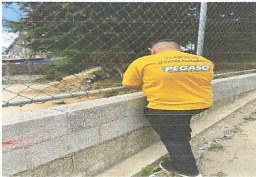
Foto 3: Levantado de hiladas de block y reparación de malla
