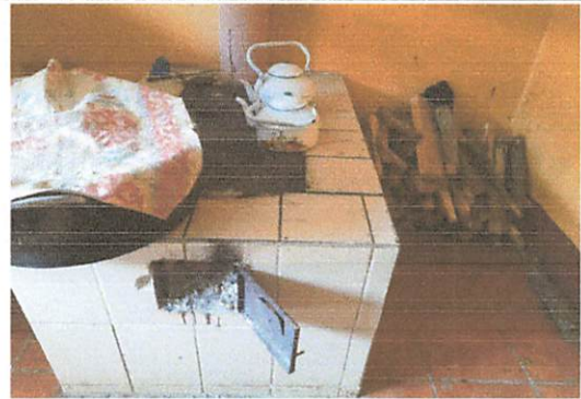
Foto 2: construcción de poyo
