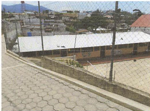
Foto 3: Levantado de hiladas de block y reparación de malla
