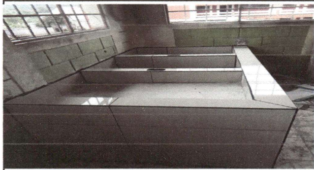
Proyecto de pila, ya finalizado
