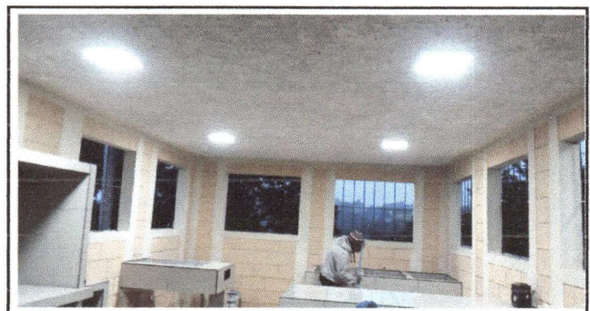
Remodelación de lámparas y de tomacorrientes
