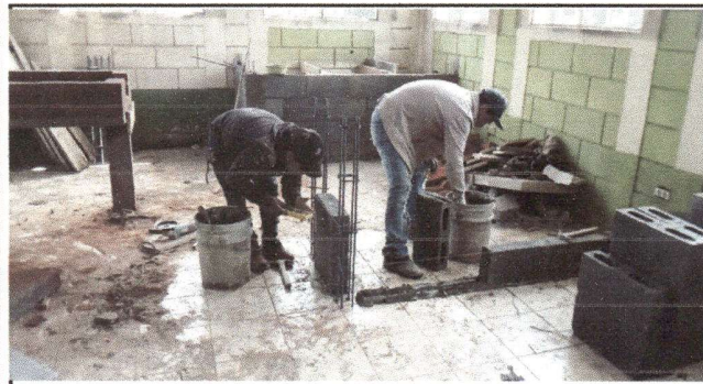
Construcción de isla
