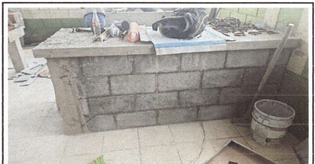
Avance de construcción de isla
