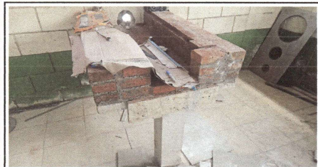
Avance de construcción de plancha
