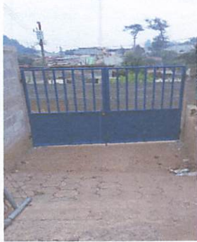
FOTO 3: Cambio y colocación de Portón Principal
