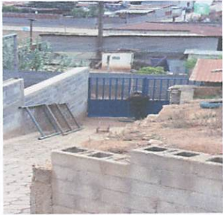
FOTO 3: Cambio y colocación de Portón Principal
