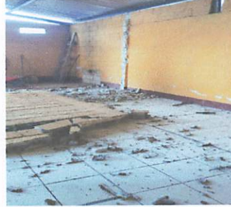
FOTO 2: Ampliación y construcción de un aula, colocación de piso cerámico.
