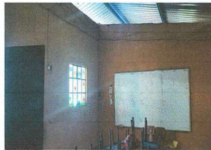
FOTO 6: Colocación de nuevas ventanas y puertas
