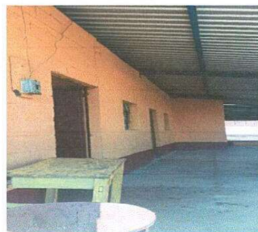
FOTO 4: Ampliación del Aula de Parvulos con repello y cernido.
