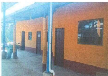
FOTO 3: Remodelación de Puertas, ventanas y piso
