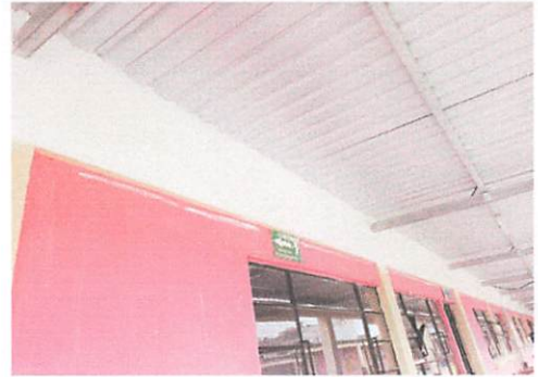
Foto 2: frente de las aulas terminado con el block y cernido.
