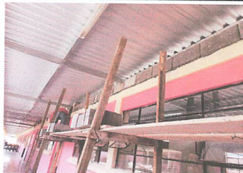
Foto 6: inicio de la colocación de block en espacios entre el techo y estructura metálica y entre aulas.
