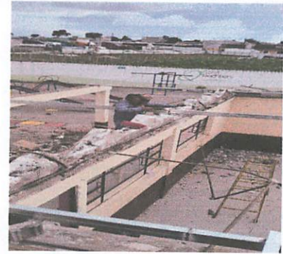
Foto 2: colocación de la estructura metálica en el área de intervención del remozamiento.
