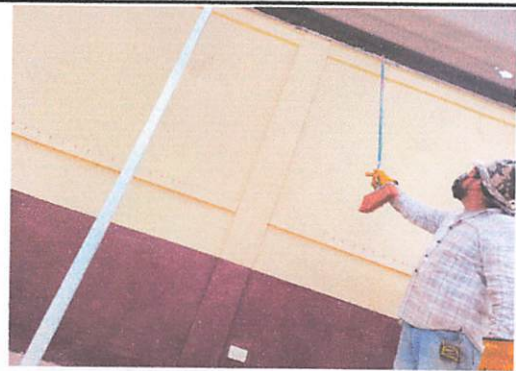
Foto 4: identificación de espacios de 30 cms. entre aulas que causan interferencia en el proceso enseñanza aprendizaje.
