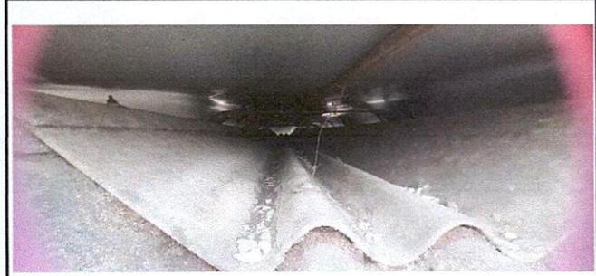
Foto1: el techado cuenta con láminas sobrepuestas debido a que se encuentran quebradas las de duralita.
