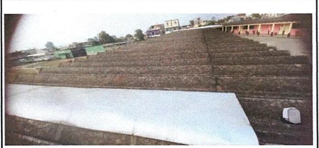
Foto 2: para evitar la filtración de agua en las aulas se han utilizado piezas de lámina.
