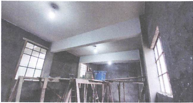
Foto1: Parte del Salon No. 1 que fue remodelado con el repello y cernido de paredes y techo de la loza .
