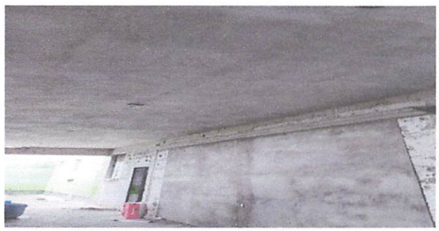
Foto 2: Parte de la pared y loza del corredor que se le esta colocando el repello y posterior cernido y tallado.
