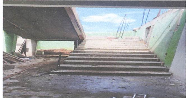
Foto 4: Proceso de construccion de las gradas.
