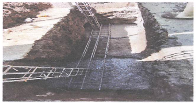
Foto 6: Cimiento de la construccion de las gradas y la bodega.
