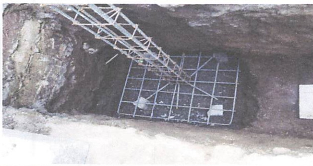
Foto 5: Es otra de las fotografias que indica el cimiento de la pared de las gradas y bodega.
