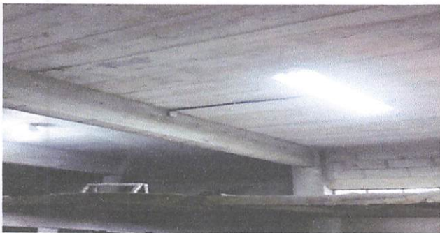
Foto 3: Parte del techo de la loza No. 2 donde sera remodelado con el repello, tallado y cernido del salon.
