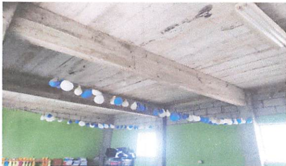
Foto1: Parte del cielo de dos salones que requiere terminar con el tallado de ambos salones con un area de 8.20 x 4.80 metros cada salon.
