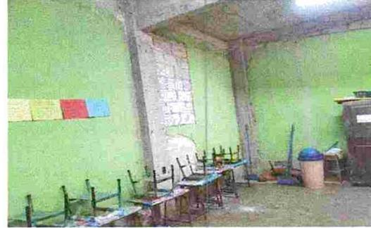
Foto 2: Parte de las paredes de ambos salones que requiere tallado por rajadura en el repello que tiene un área de Largo 8.20, Ancho 4.80 y Altura 3.38 metros por cada salón.
