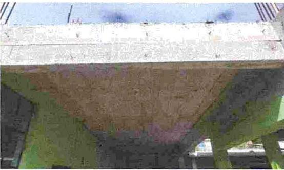
Foto 3: Parte del Cielo del corredor que tiene un área de 11.20 x 2.85 metros que necesita terminar con el Tallado.
