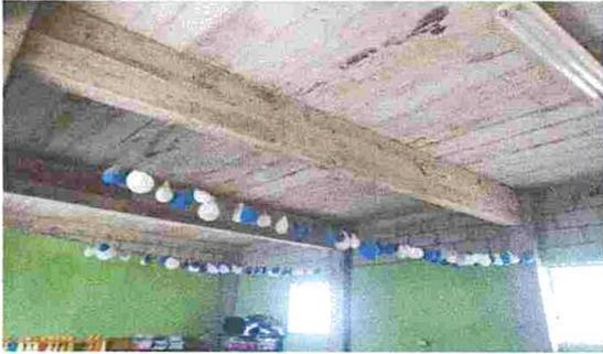
Foto 1: Parte del cielo de dos salones que requiere terminar con el tallado de ambos salones con un área de 8.20 x 4.80 metros cada salón.
