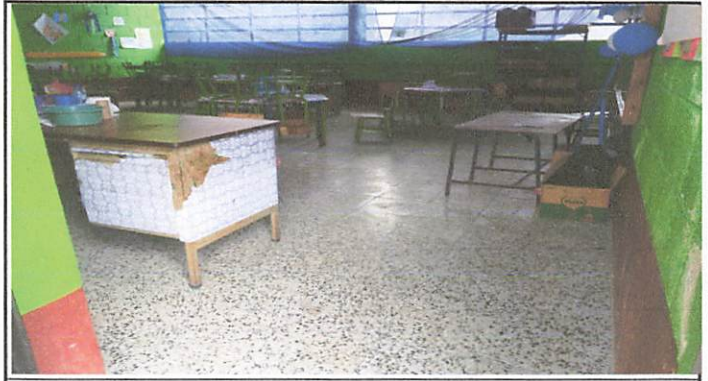
Foto 8: colocacion de piso finalizado. En Preprimara A
