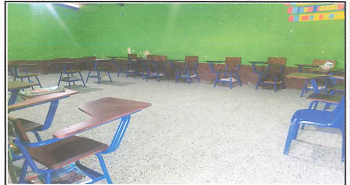
Foto 4: Colocación de piso ya finalizado. En quinto grado A
