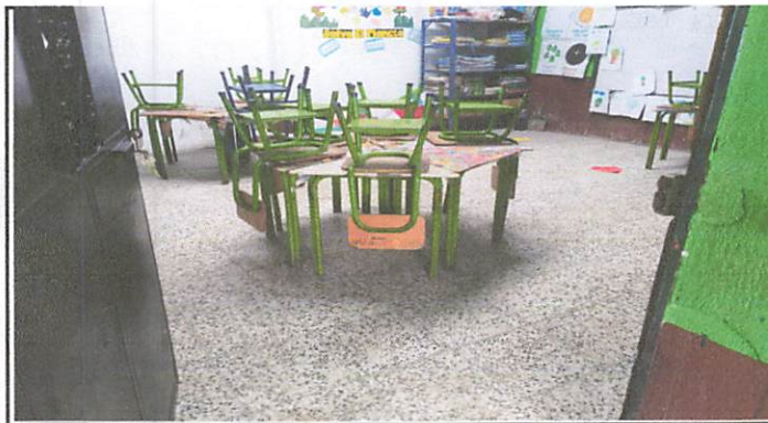
Foto 9: colocacion de piso finalizado. En Preprimara B.
