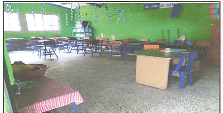
Foto 6: colocación de piso y apertura de ventana finalizado. En quinto grado B.
