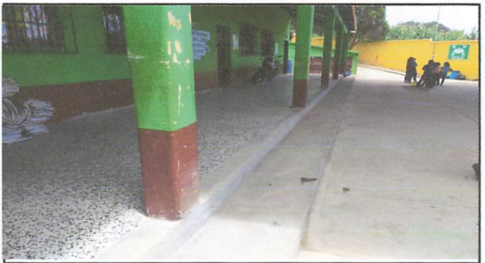
Foto Banqueta finalizada del patio A.
