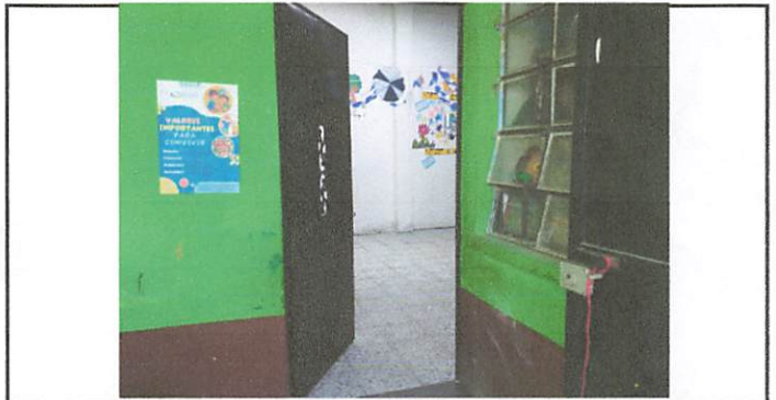
Foto 12: Puertas instaladas y cortada por colocación de piso.
