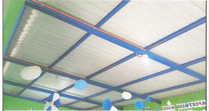
Foto 2: Instalción de claves dentro de ducto finalizado.
