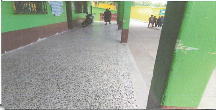
Foto7: 10: colocacion de piso en el corredor finalizado. En corredor de patio A.
