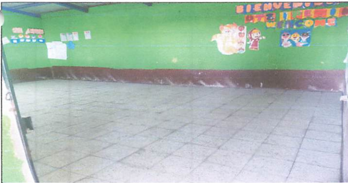
Foto 5: Colocación de piso finalizado. Primer grado A.
