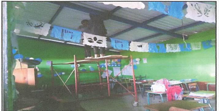
Foto 6: Colocación de cables electricos dentro de ducto para resguardar la integridad fisica de alumnos.
