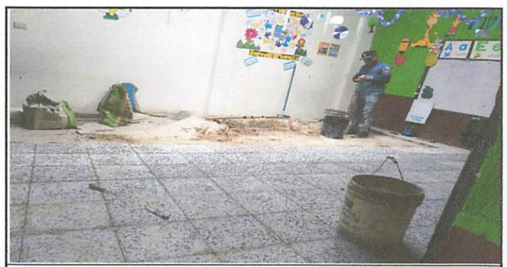
Foto 12: avance de colocacion de piso de granito . En Preprimara B.
