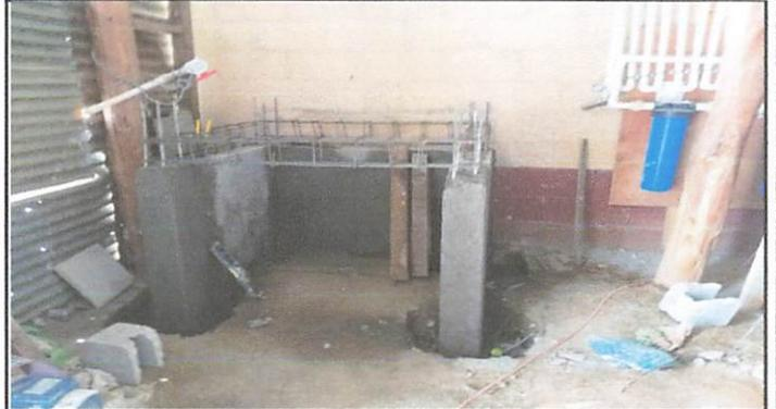
Foto 2: Levantado de pared y primeras armaduras.
