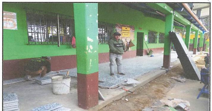
Foto 10: avance de colocacion de piso de granito . En corredor de patio A.
