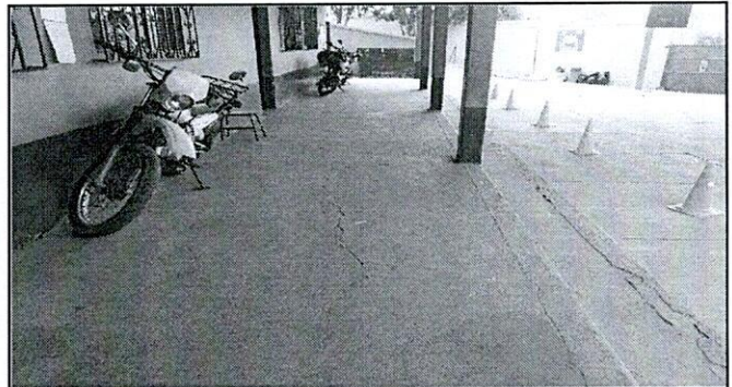
Foto 10: colocación de piso en el corredor ya que el existente es solo de cemento. En corredor de patio A.
