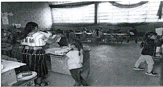
Foto 11: colocación de piso ya que el existente es solo de cemento. En Preprimara A
