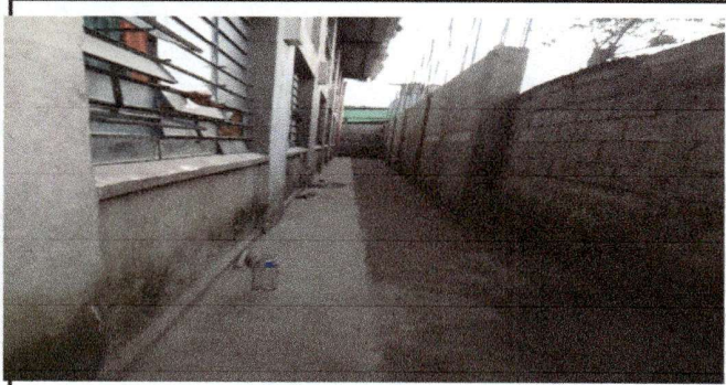
Foto 1: Finalización Muro de concreto
