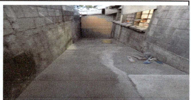
Foto 2: Pavimentación entrada a muro perimetral
