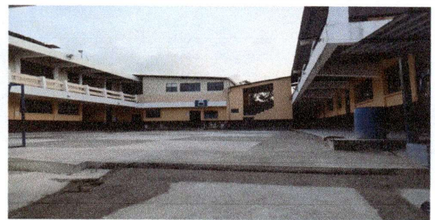
Foto 4: Proceso del patio de concreto
