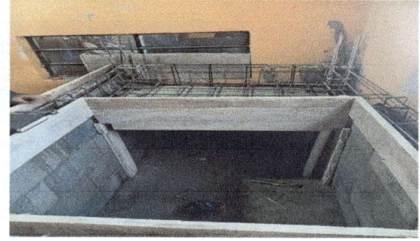
Foto 8: Construcción de Pila
