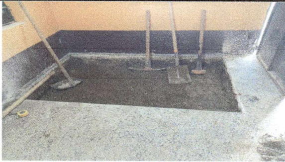
Foto 7: Durante construcción de pila
