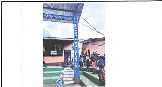
ESTRUCTURA DE TECHO
