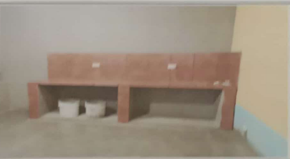
Foto 5: Culminación de la obra gris
