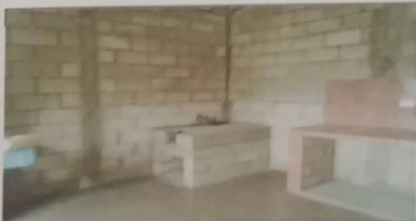
Foto 5: Proceso sobre la reconstrucción de la cocina.
