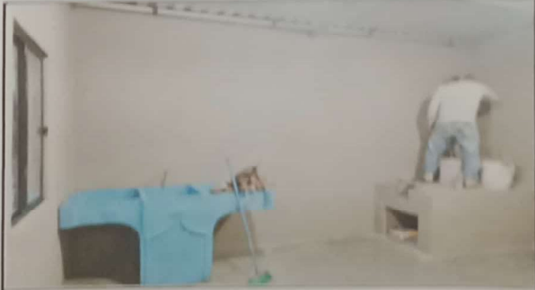
Foto 6: Trabajando en la obra gris.
