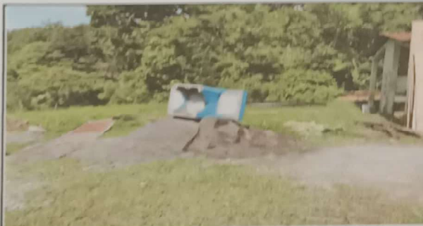
Foto 3: Material para la reconstrucción de cocina.
