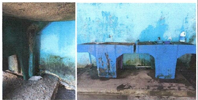
Foto 6: Cambio de pilas
