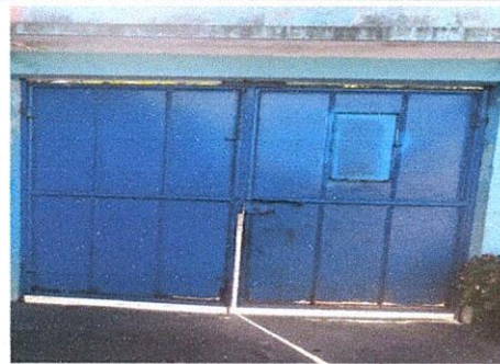
Foto 8: Reparación del portón y cambio de chapa
