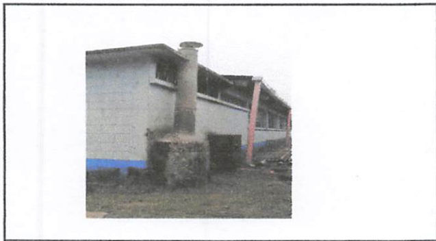
Foto 3: finalizacion de chimenea de cocina.
