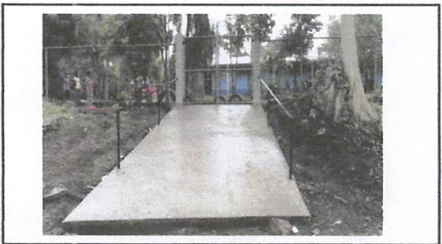
Foto 4: finalizacion de rampa posterior.
