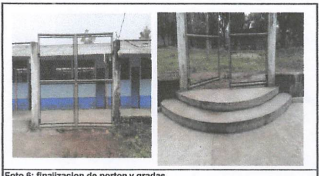
Foto 6: finalizacion de porton y gradas.
