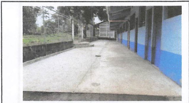
Foto1: finalizacion de proyecto terminado del pavimento
