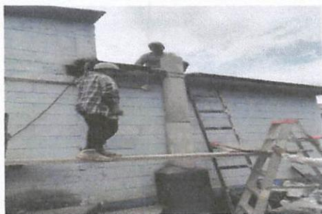
Foto 5: proceso de construcción de la chimenea de la cocina
